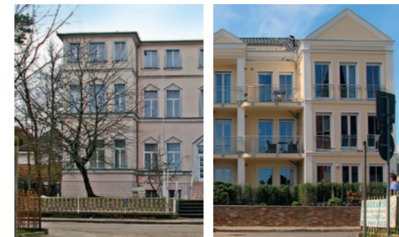
Aus dem Hotel Bütow in Ahlbeck wurde das „Dünen Palais“
